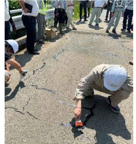
自治体職員による簡易路面補修
