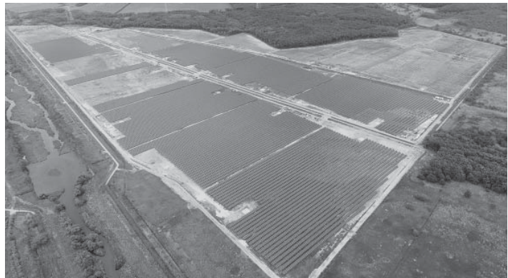
現場南側からの全景 モジュール取付 約40% (6月16日撮影)
