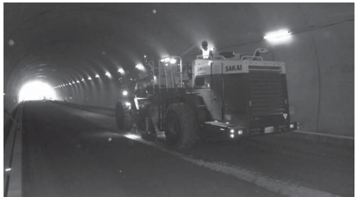
上層路盤工セメント改良施工中
