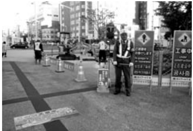
照明施設工(照明柱基礎) 掘削工・施工中
