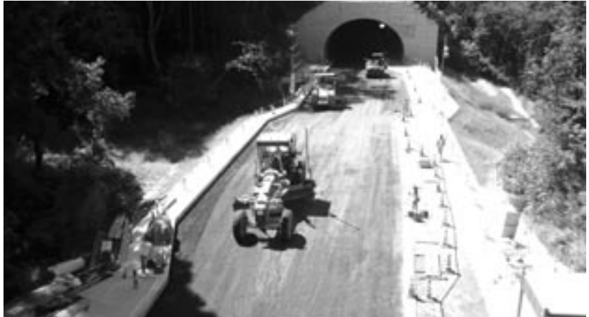
コンクリート舗装工上層路盤敷均し、転圧状況
