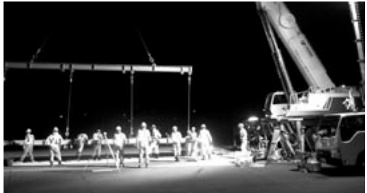
夜間作業 PRC版据付
