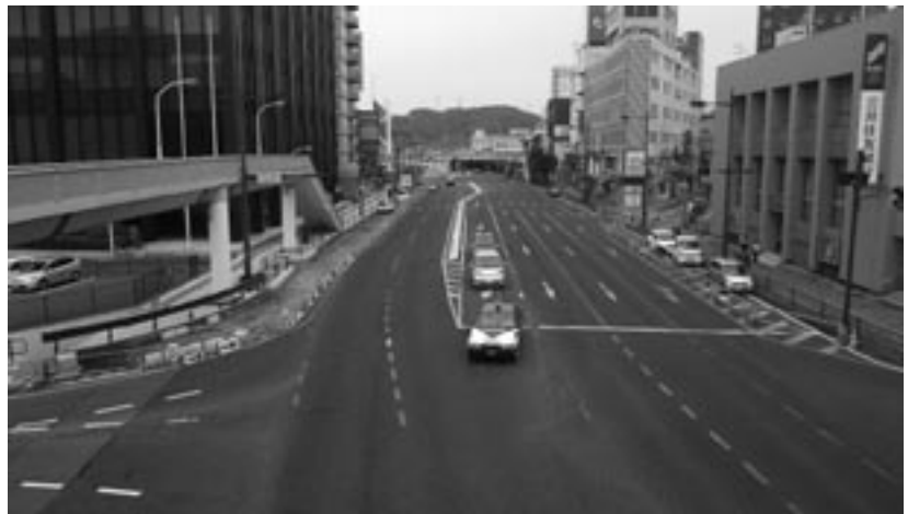
施工前写真(歩道橋より下関駅前を臨む)
