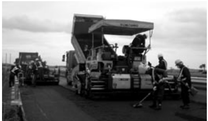
中間層工施工中
