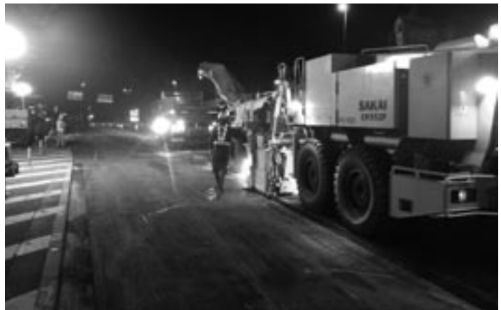
夜間工事 切削オーバーレイ
