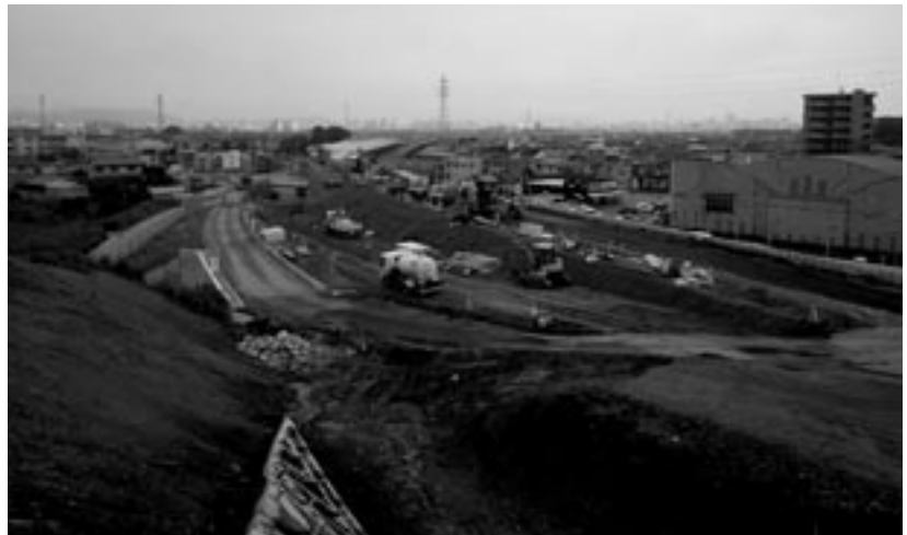
和歌山岬道路本線とOFFランプ
