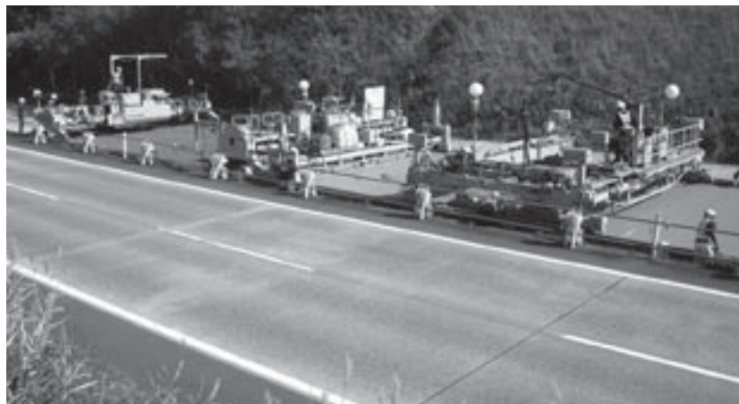
コンクリート舗装 作業状況
