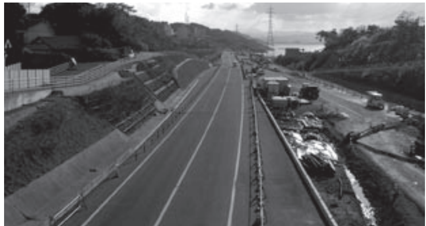
左側：供用中、右側：新設部（現場終点側より撮影）
