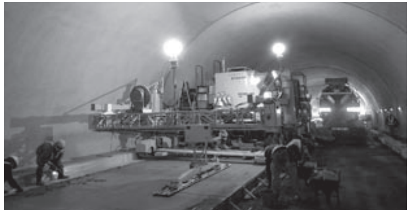
コンクリート舗装(スリップフォーム)施工状況
