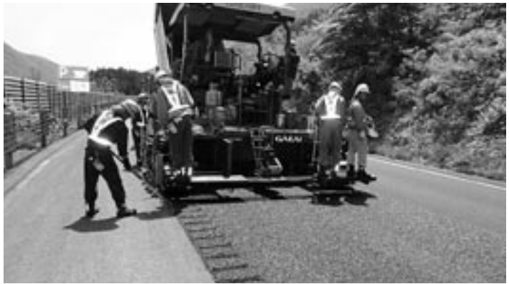
注意喚起施工状況
