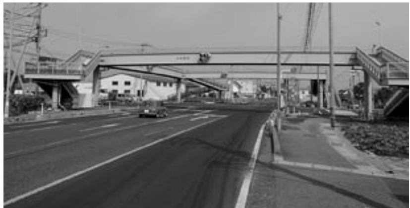
陸橋の下付近が施工箇所です
