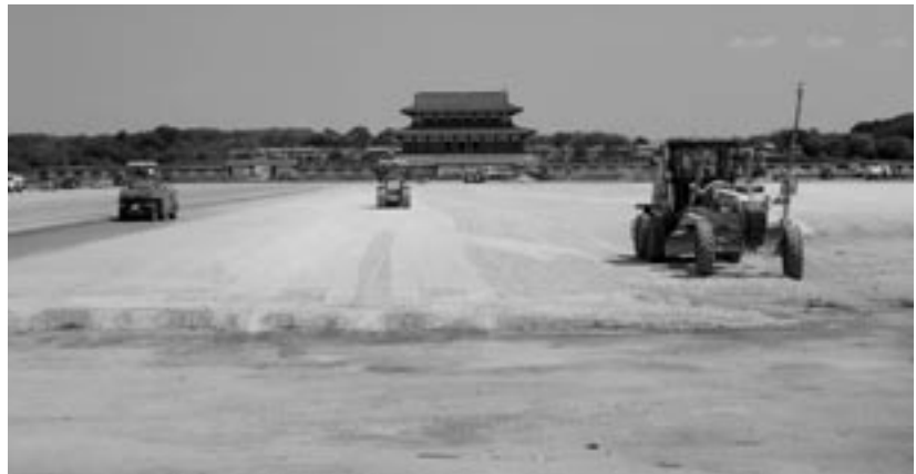
マシンコントロール技術での敷均し状況（後方中央は復元された大極殿）
