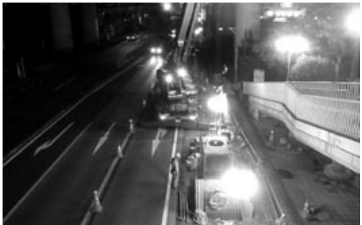
特殊部工 据付状況
