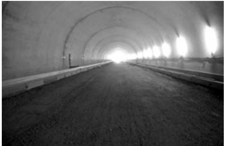
側溝敷設完了
