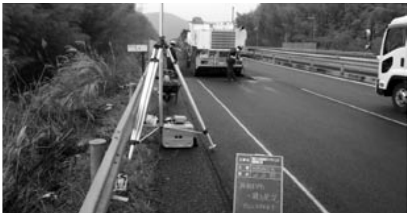
路面切削状況(マシンコントロール)
