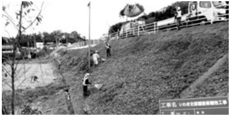
除染工 法面除染状況
