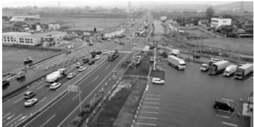
工事中間点から終点方向を望む
