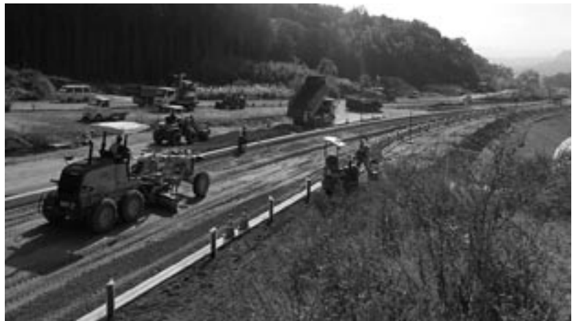
本線 上層路盤施工状況
