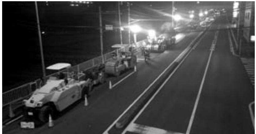
切削オーバーレイ施工状況
