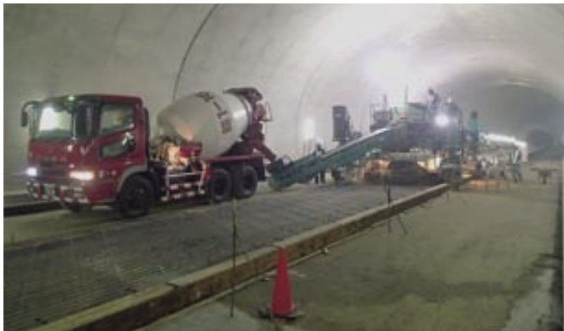
スリップフォーム工法による連続鉄筋コンクリート打設状況
