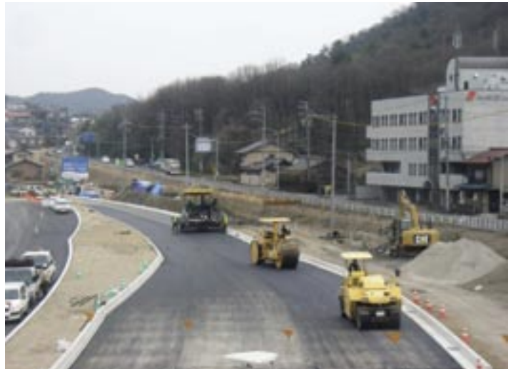
基層施工状況
