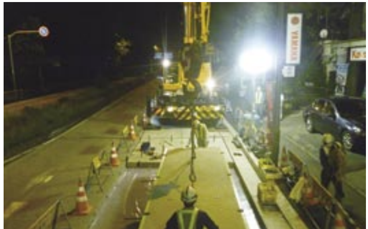
道路用PRC版施工状況
