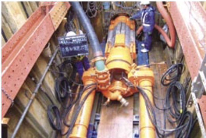
推進工(エースモール工法)先導体推進状況
