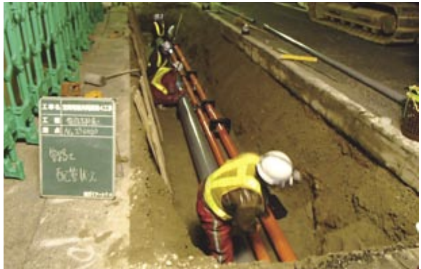
管路施工状況
