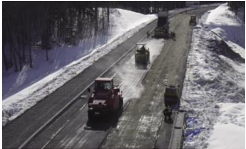
起点明部の舗設状況
