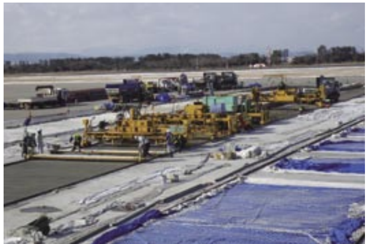
コンクリート舗装 施工状況
