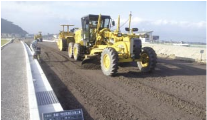
本線車道施工状況
