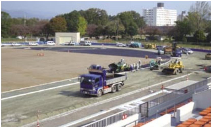
全天候型舗装 舗設状況
