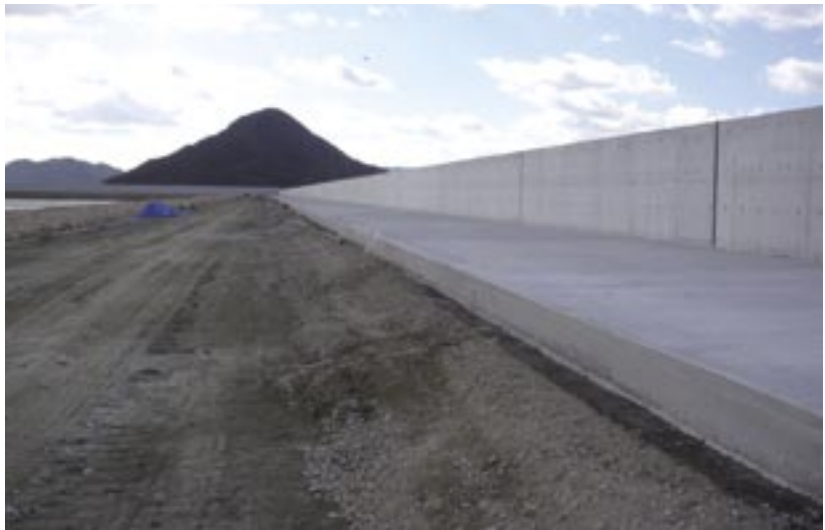
C護岸 コンクリート舗装施工
