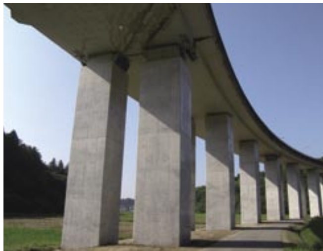
巻きコンクリート工・落橋防止工の竣工写真
