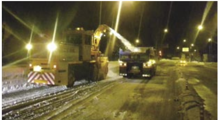
IC間の封鎖を伴った運搬排雪状況
