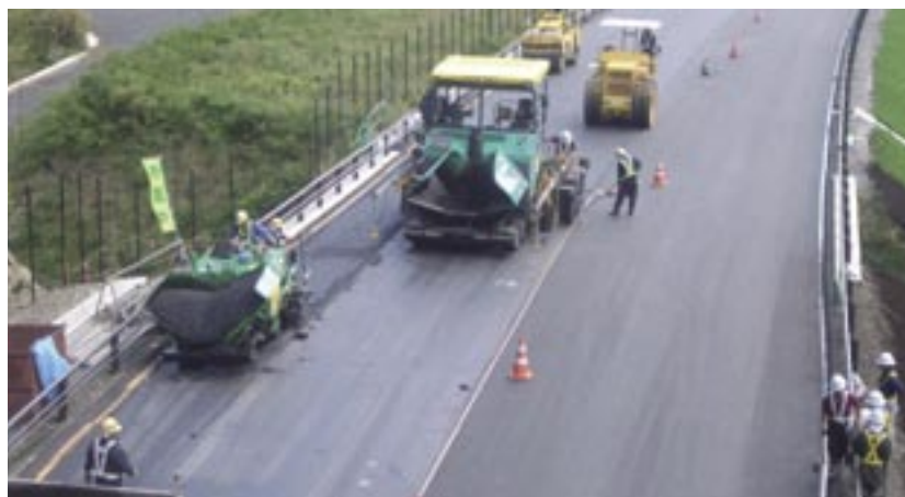
ミニフィニッシャーを併用しての表層施工状況
