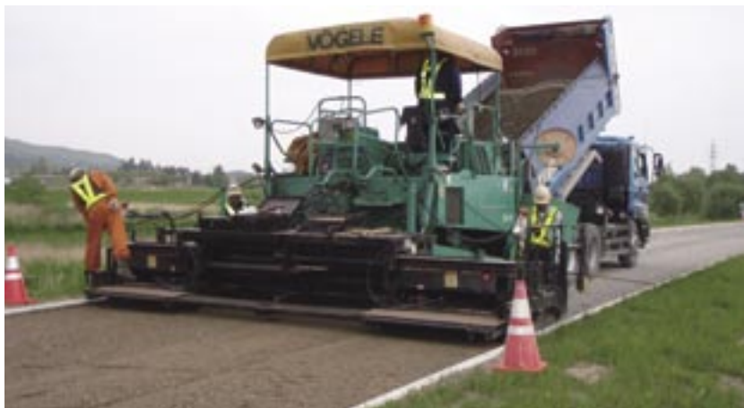
フィニッシャーで路盤を敷均しの実施
