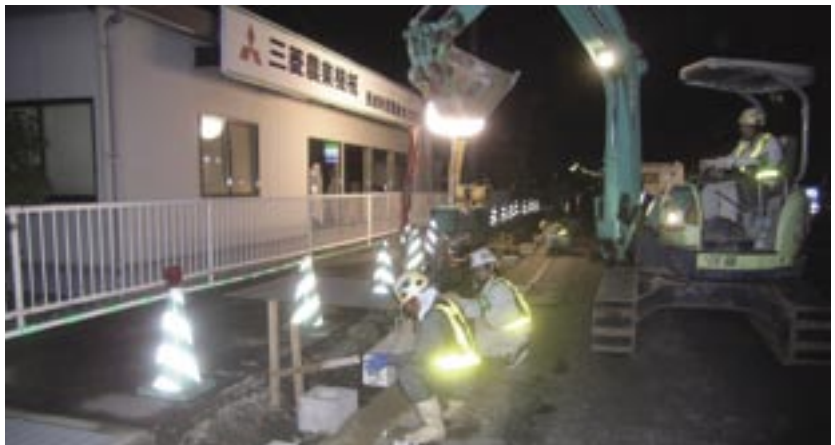
縁石据付状況
