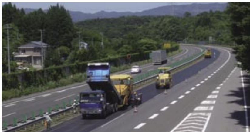
施工中の現場
