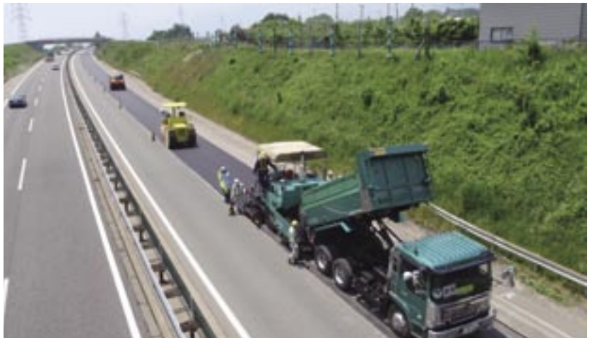
本線舗設状況
