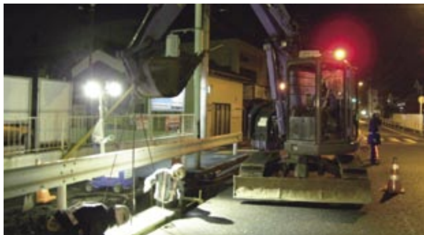
街渠縦断管φ400施工状況
