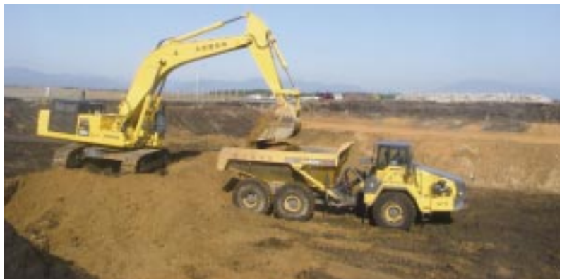
盛土材の積込状況。3m 3 BHと36t ダンプ
