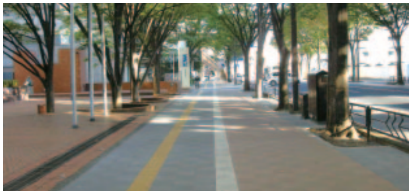
歩道保水性平板完了部分
