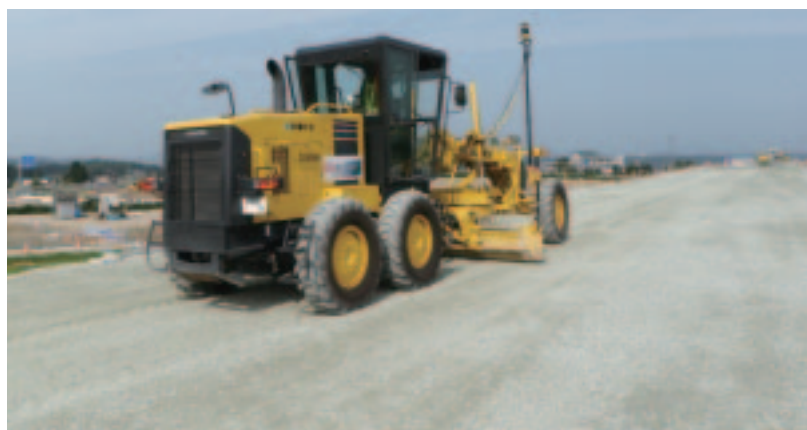
mmGPS機能付グレーダーで下層路盤の施工状況
