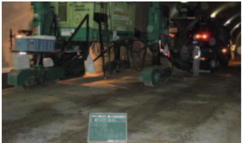
円形側溝（スリップフォーム）施工状況
