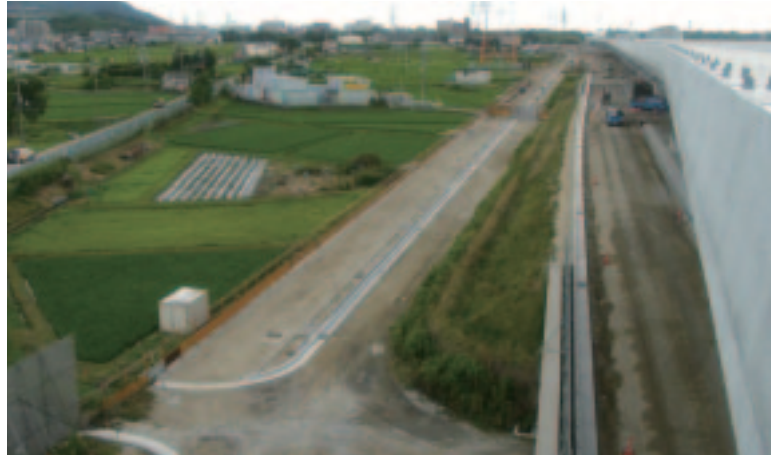
第二京阪道路（高速道路）より、当現場（大阪北道路下り線）を望む。
