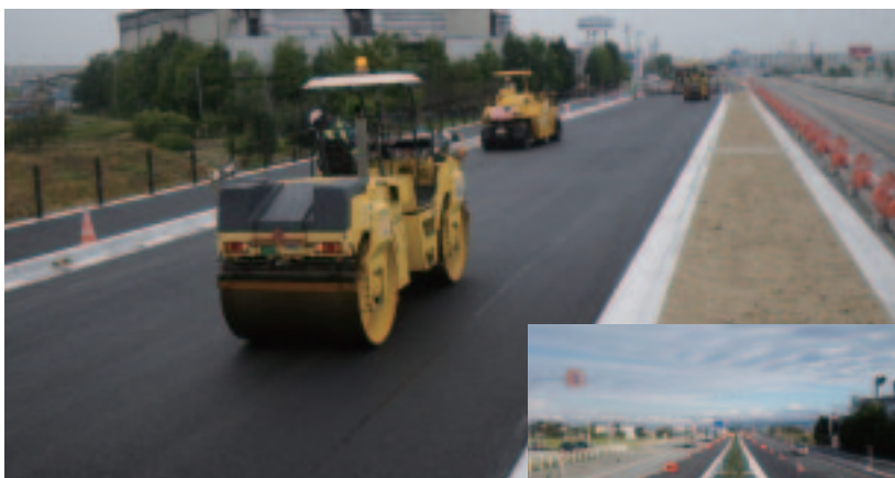
本工事は国道8号の4車線化舗装工事です。
