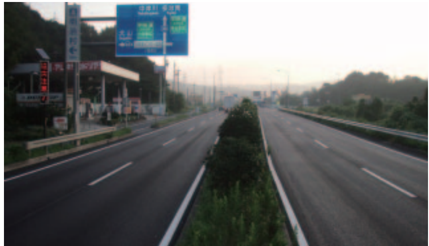
工事起点 舗装完了
