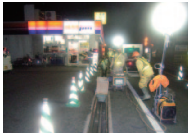
W2R工法の施工状況
