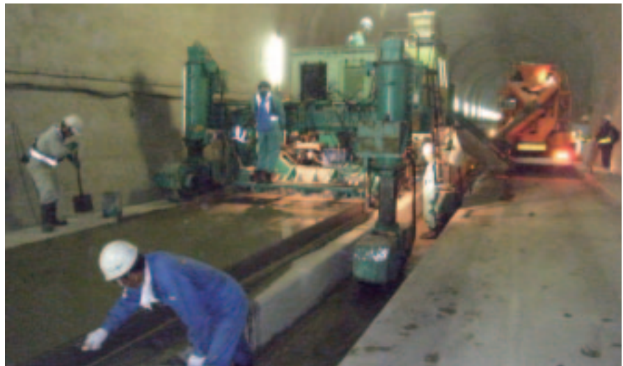
スリップフォーム工法による路盤鉄筋コンクリート打設状況
