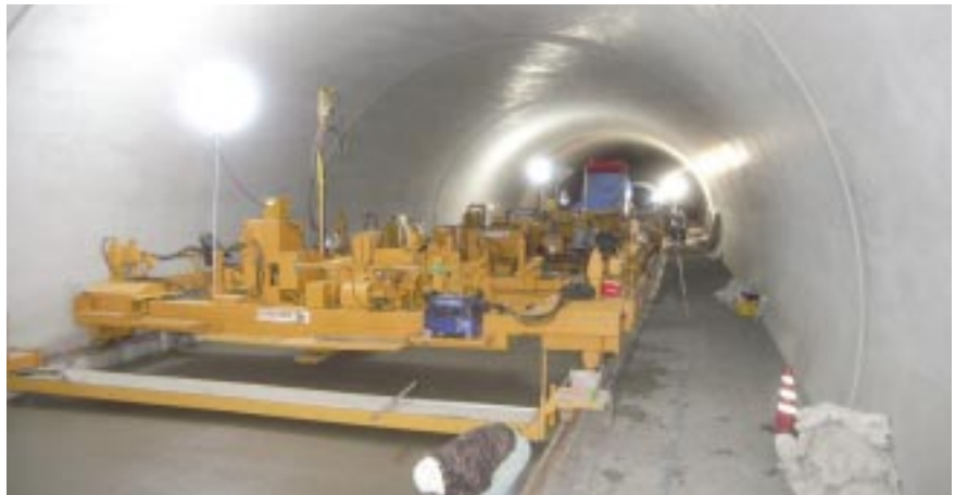
大浦トンネルコンクリート舗装工 施工
