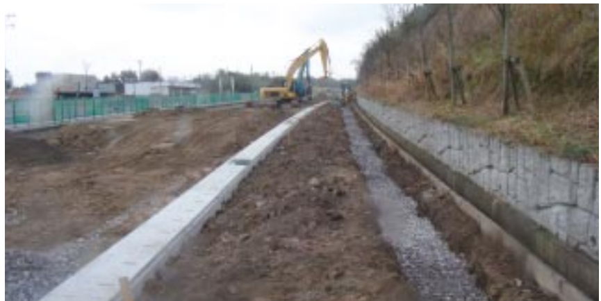
部分着工箇所の管渠工部
