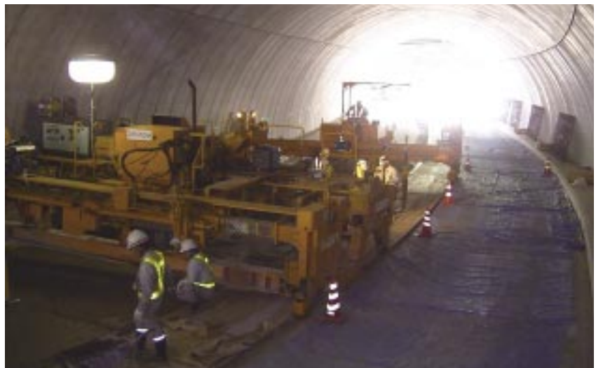
楡原トンネル コンクリート舗装工 施工状況
