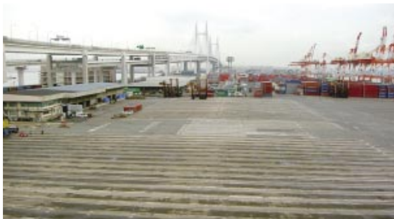
工事着手前の施工現場 ほぼ全景です。
