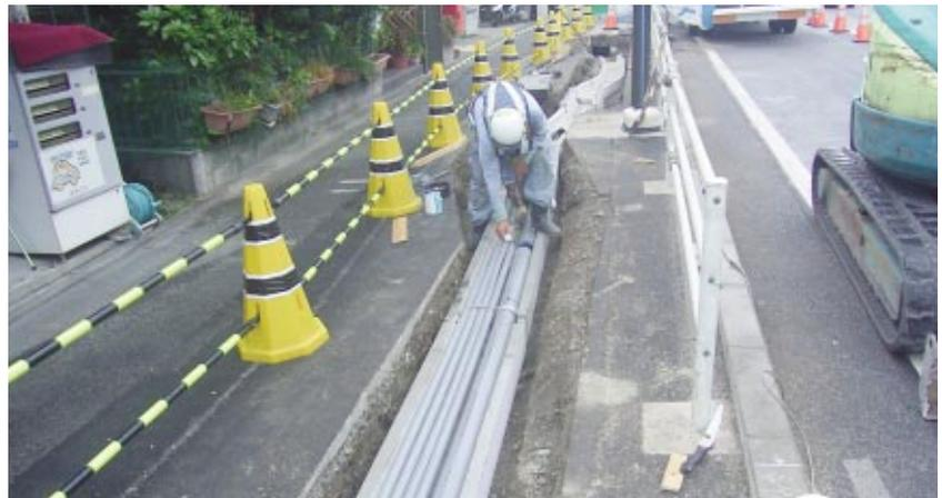
次世代型電線共同溝、トラフ部布設状況
