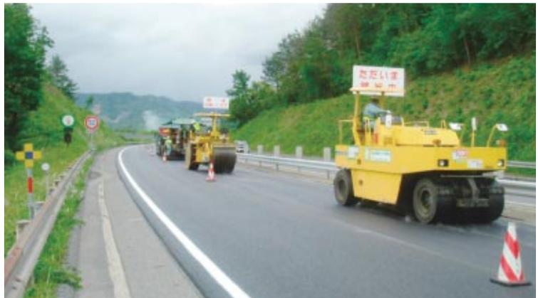
表層工の施工中 (千代田IC付近)
