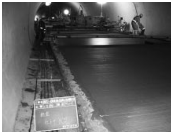
全断面機械で施工中の木岐第1トンネル
