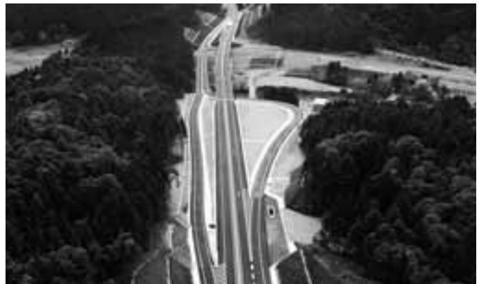
此木ランプ橋を中心に上がCランプ、下がD、Aランプ、右にEランプ
